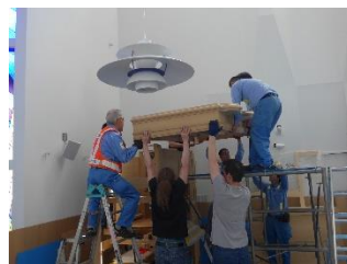
一番重い風箱を設置
