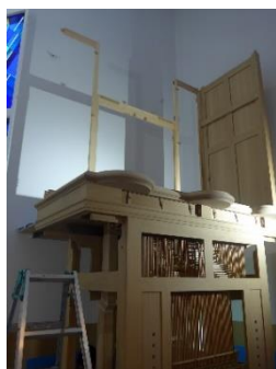
礼拝堂での組立の様子
